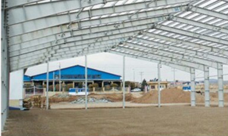
ساخت و نصب سوله و سازه شرکت ترمال سرامیک وزن: ۱۲۰۰ تن
