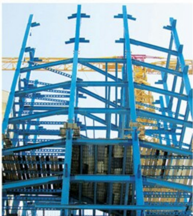
ساخت و نصب سازه فلزی ساختمان مسکونی تهران - زعفرانیه وزن: ۵۷۰ تن
