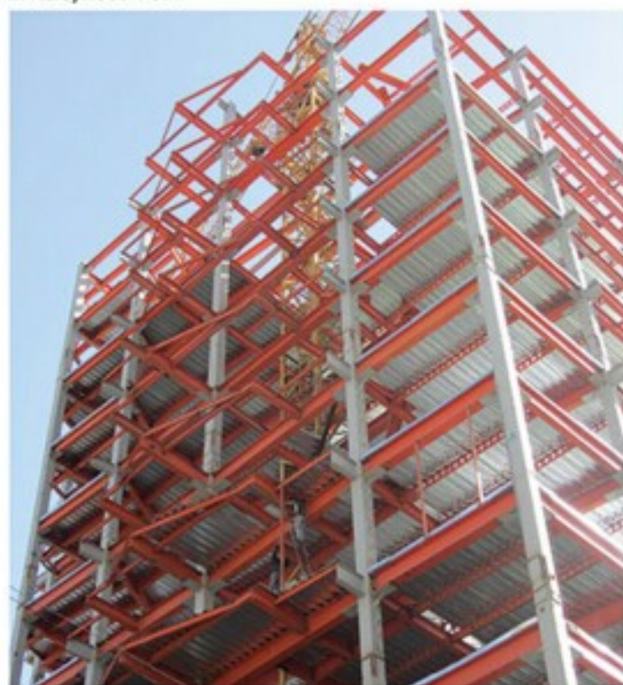
ساخت و نصب سازه فلزی ساختمان مسکونی کرج وزن: ۵۵۰ تن
