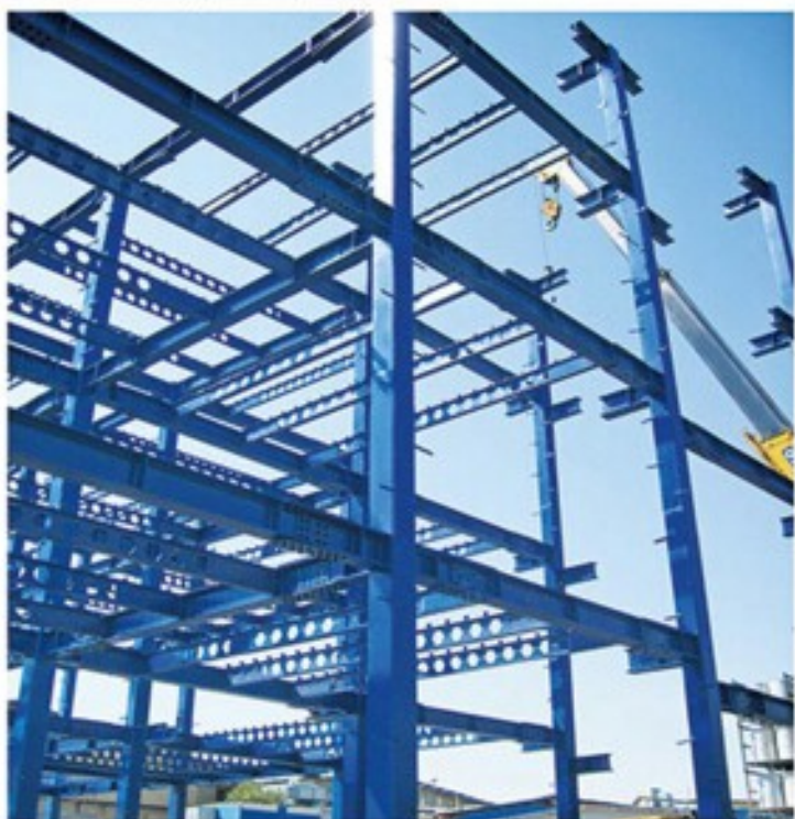
ساخت و نصب سازه فلزی ساختمان اداری شرکت عالی فرد (سن ایچ) وزن: ۳۶۰ تن
