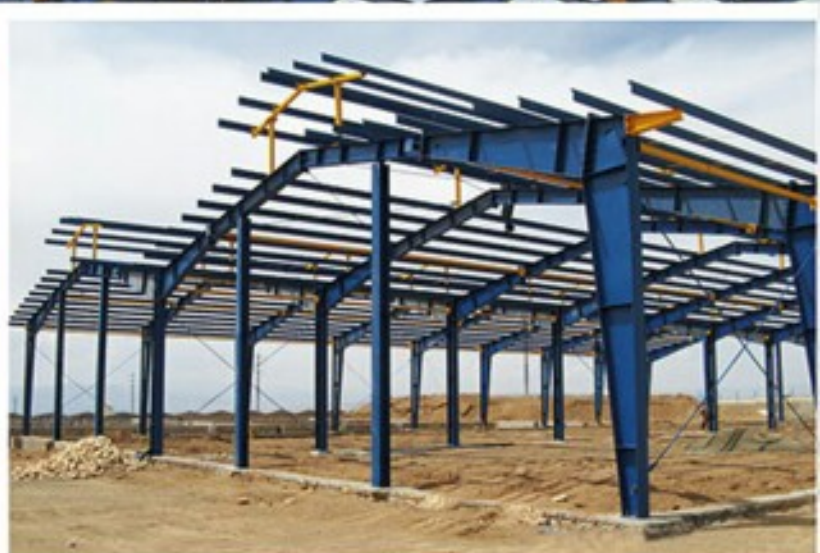
ساخت و نصب شرکت زر ساب (تولید کننده ظروف تفلون) / وزن: ۱۸۰ تن Fabrication and Erection of the Steel Structures of Zarsab Company (Teflon Dishes Manufacturer) / 180 TON
