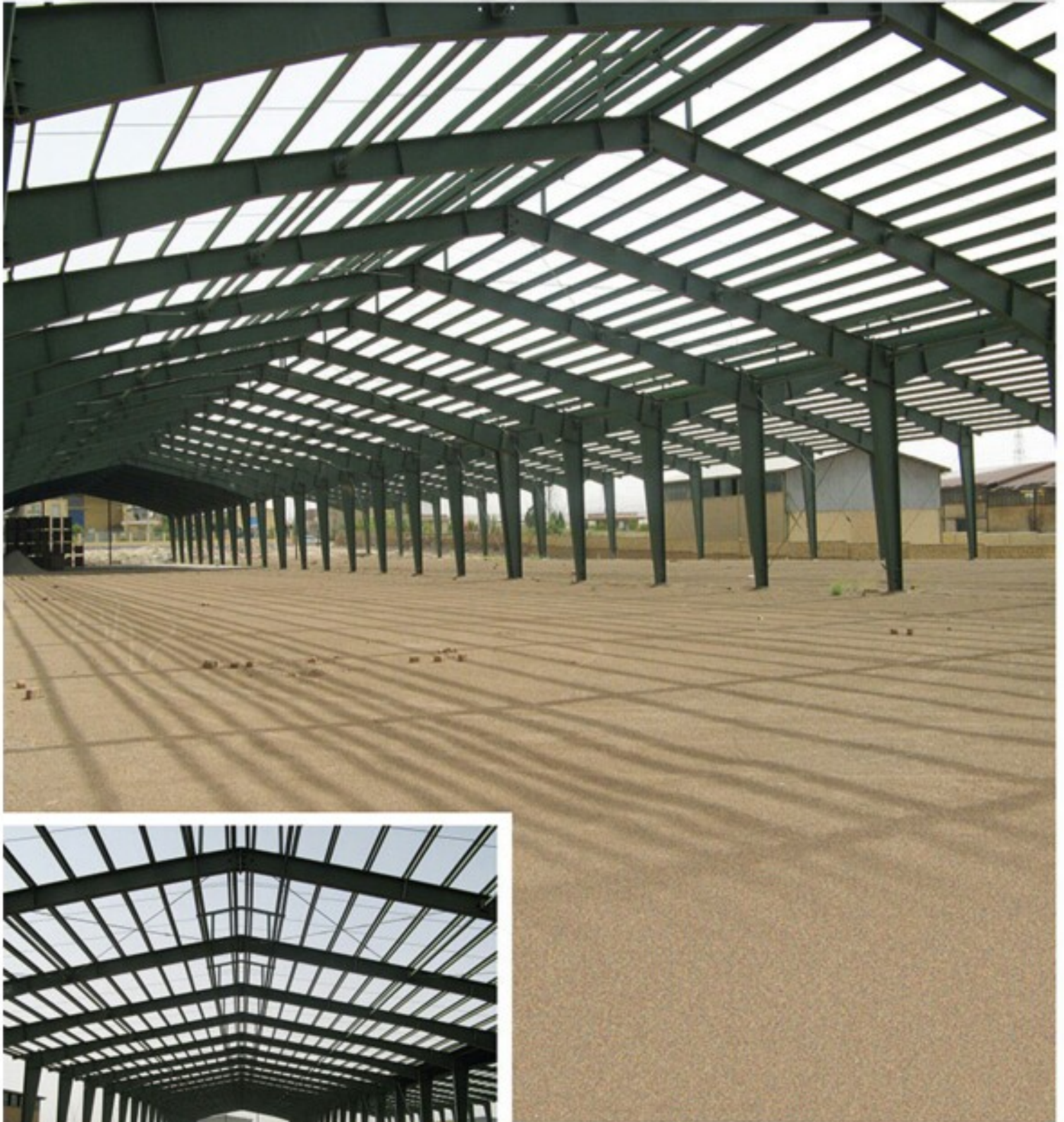
ساخت و نصب سوله شرکت سرام نگار / وزن: ۴۶۰ تن
