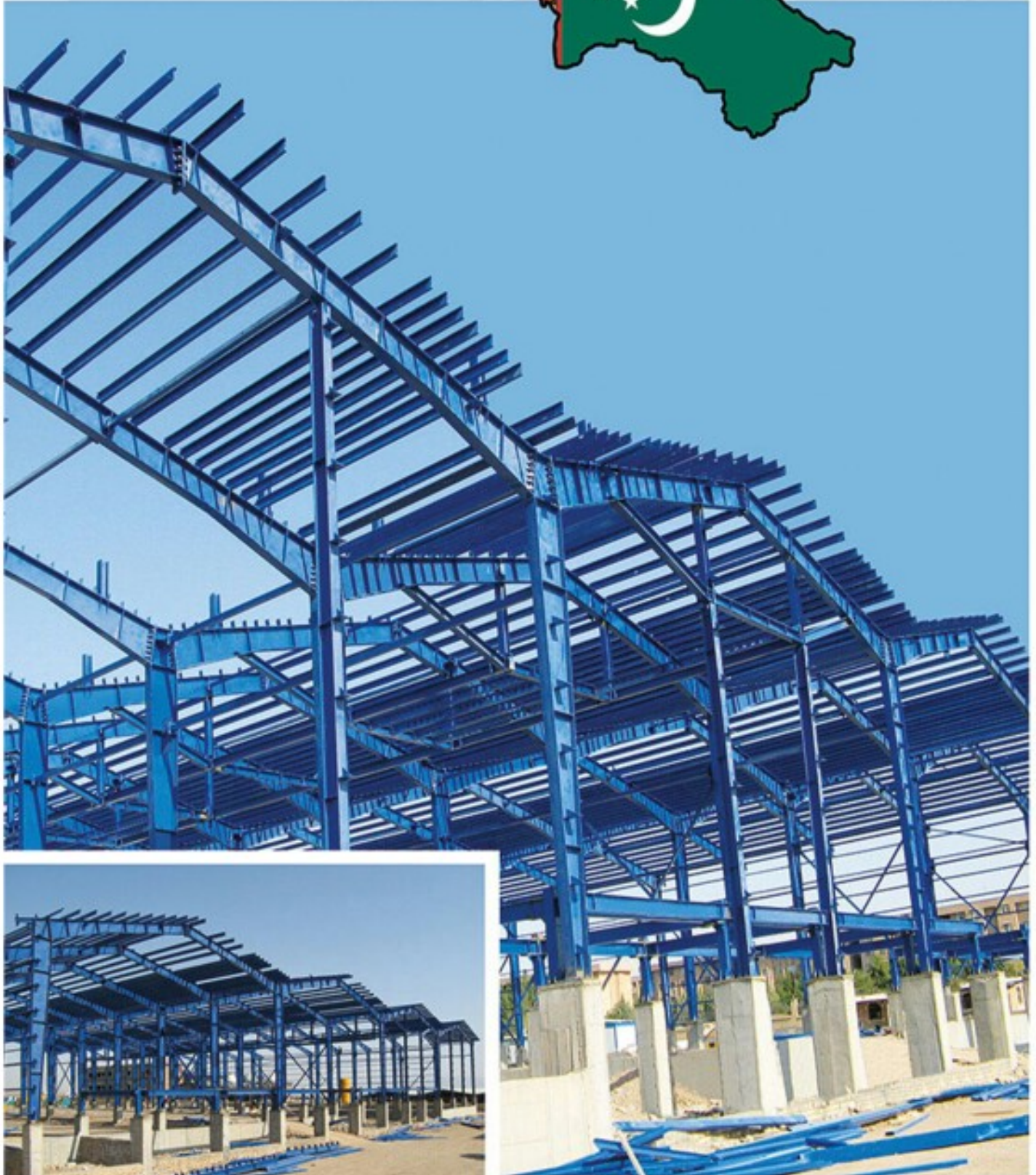
ساخت و نصب سوله در کشور ترکمنستان / وزن: ۱۹۵۰ تن Fabrication and Erection of Steel Structure Projects in Turkmenistan / 1950 TON
