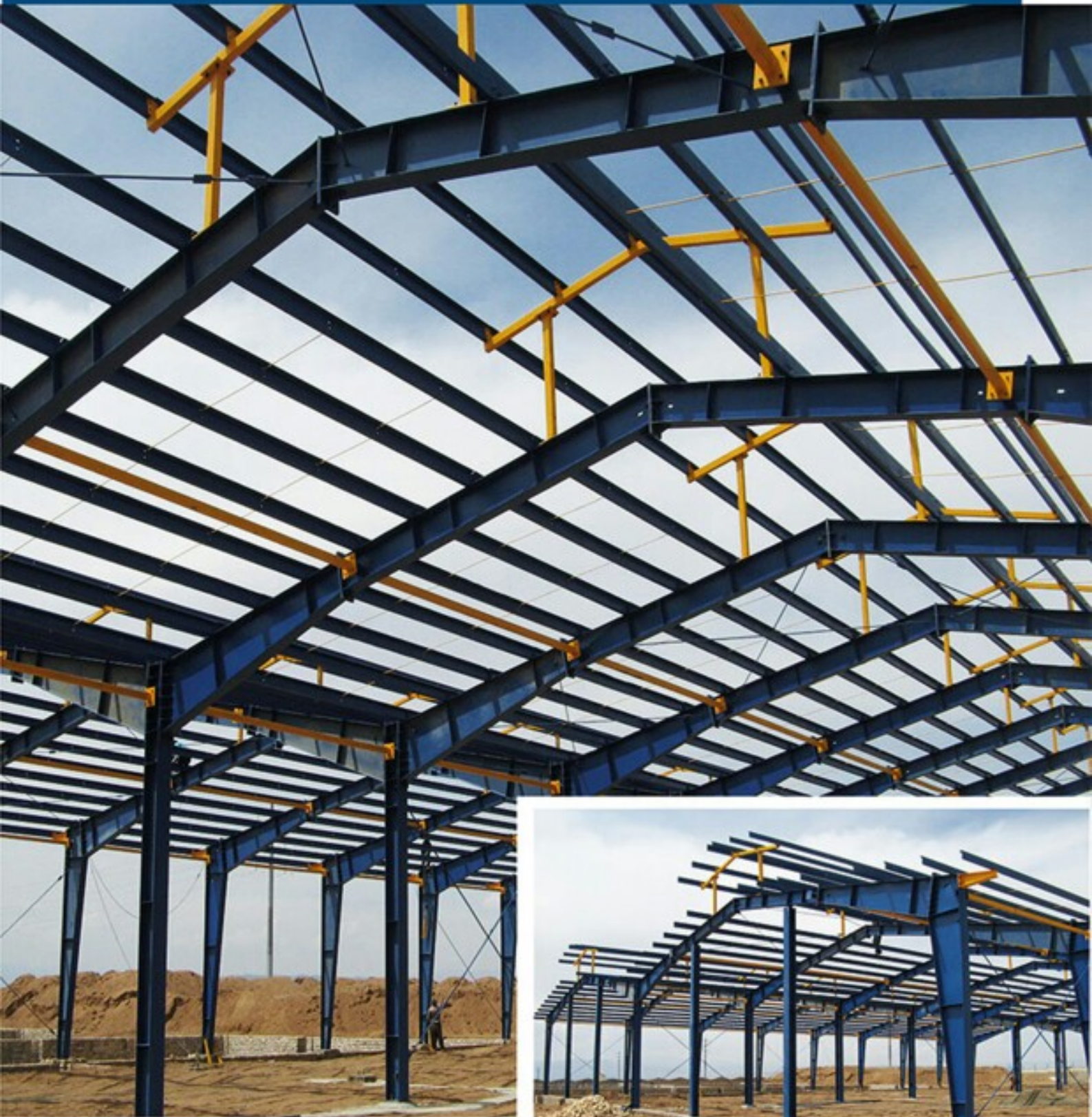
ساخت و نصب شرکت زر ساب (تولید کننده ظروف تفلون) / وزن: ۱۸۰ تن Fabrication and Erection of the Steel Structures of Zarsab Company (Teflon Dishes Manufacturer) / 180 TON
