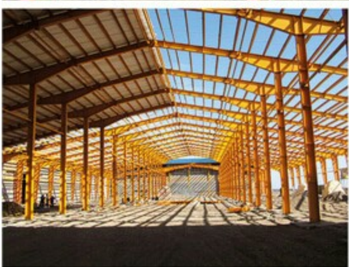
ساخت و نصب سوله های شرکت طلا چین (چیپس باتو) / وزن: ۱۴۰۰ تن Fabrication and Erection of the Steel Structures of Talachin Company (BATO Chips Manufacturer ) 1400 ton
