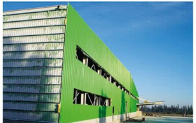
ساخت و نصب سوله در کشور افغانستان / وزن: ۷۰۰ تن Fabrication and Erection of Steel Structures in Afghanistan / 700 ton
