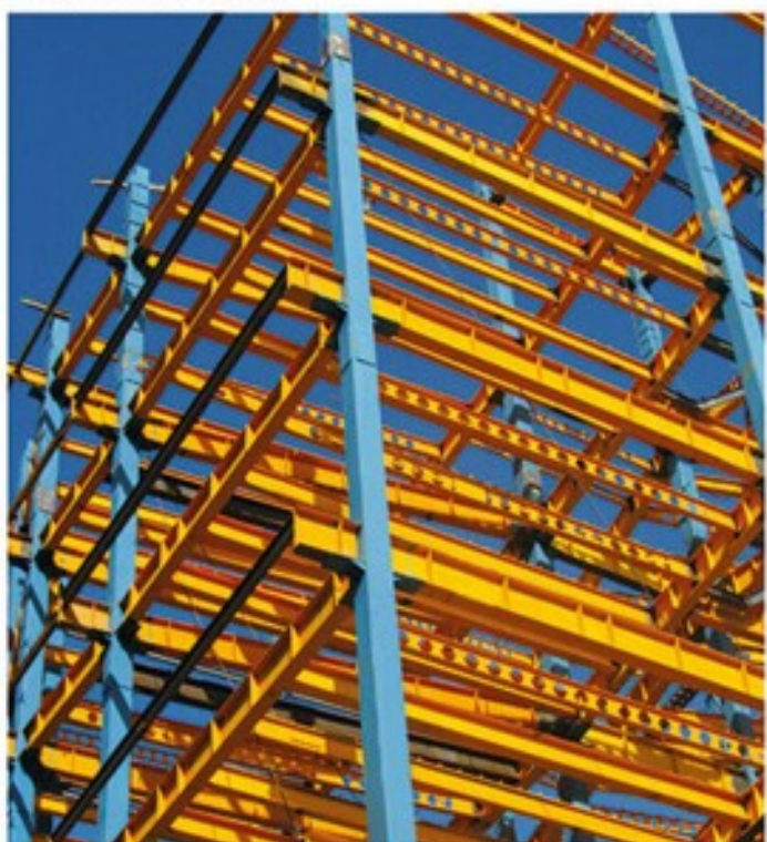
ساخت و نصب سازه فلزی ساختمان مسکونی تهران - نیاوران وزن: ۳۷۰ تن
