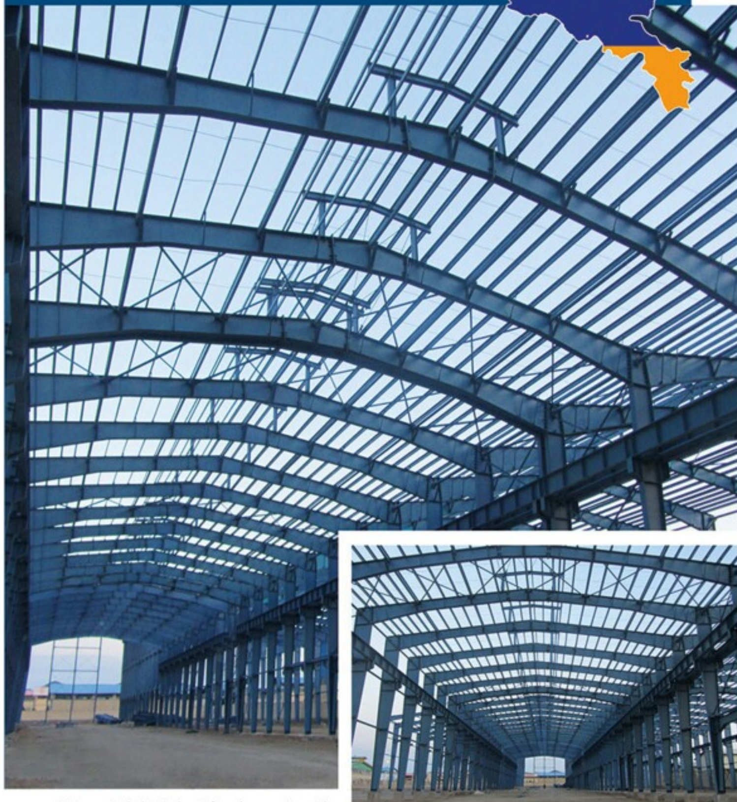
ساخت و نصب سوله در کشور ارمنستان / وزن: ۱۱۰۰ تن Fabrication and Erection of Steel Structures in Armenia / 1100 ton
